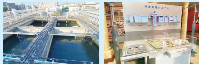
取水場は大阪市、浄水場は尼崎と猪名川に位置
