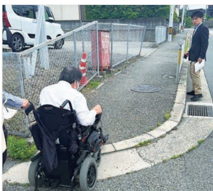
車椅子やベビーカーで越えにくい段差がたくさん 県土木へ対応を依頼(可能な箇所から対応予定)
