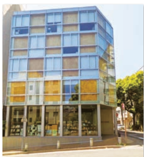
兵庫県林業会館 (債権放棄で建物は無償で譲渡)
