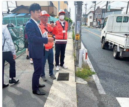
中八木駅前の歩道の凹凸や危険箇所を 地元自治会やスクールガードと確認し、 県土木へ対応を依頼(一部対応済み)
